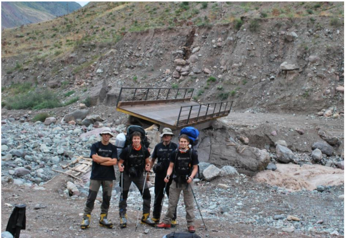
Nuotrauka 1. Nepravažiuojamas tiltas per vieną iš Muk upės intakų.
